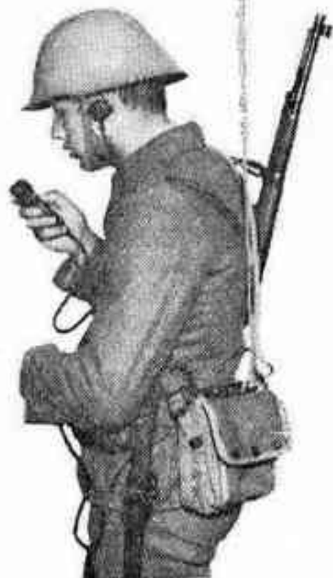
Sl. 16 — Postavljanje radio-uređaja RUP-33 kao prenosne radio-stanice
